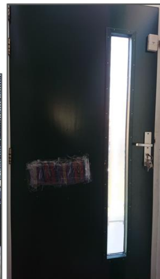
De voordeur (en specifiek brievenbus): een plek waar kou en tocht vaak binnenkomt
